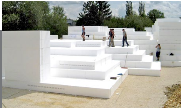
Straßenbauobjekt Bundesstraße 33, Blaustein bei Ulm
