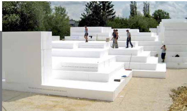
Straßenbauobjekt Bundesstraße 33, Blaustein bei Ulm
