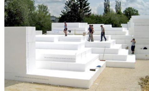
Straßenbauobjekt Bundesstraße 33, Blaustein bei Ulm
